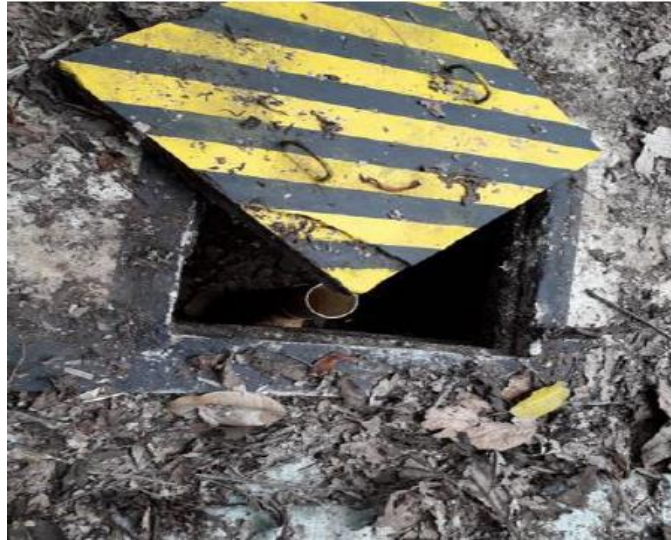
Sistema de tratamiento
