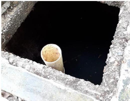
Sistema de tratamiento
