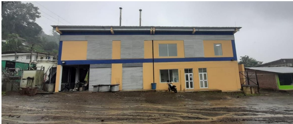
Imagen 8. Fachada principal de la central de generación
