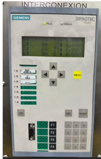
Relé de protección Siemens SIPROTEC 7SJ62
