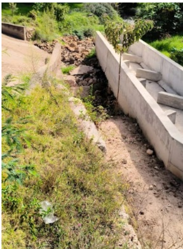
Fotografía 1. Socavación canal
