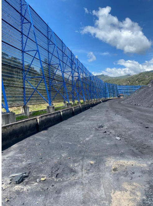
Fotografía 1. Condiciones actuales del cerramiento
