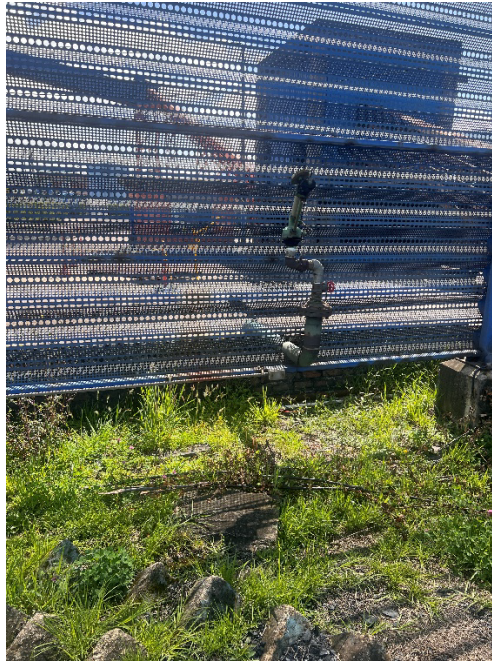
Fotografía 3. Cableado de aspersores.
