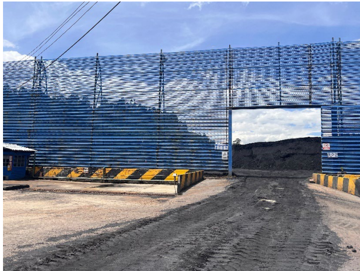
Fotografía 2. Portón de acceso a patio de carbón.
